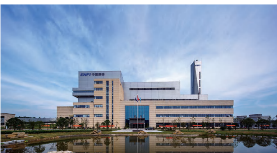
6. 赣州智慧垃圾焚烧厂建设项目
